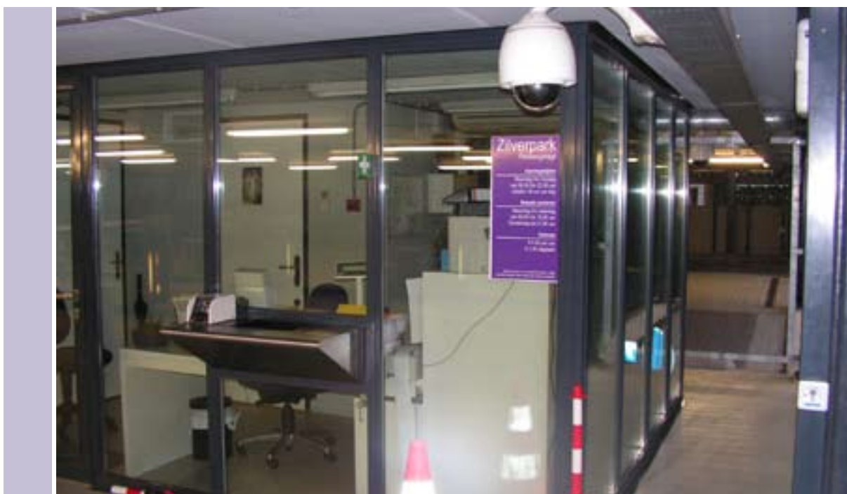
Een goed zichtbaar kantoor en camerabewaking in de Zilverparkgarage in Lelystad.
